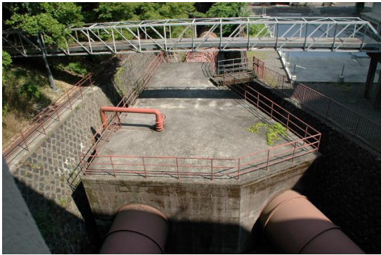
左右に分岐する導水路、発電機を回した後、疏水へ放流される
