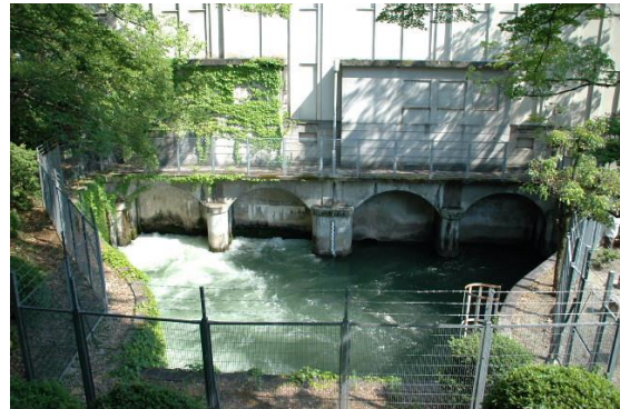
左右に分岐する導水路、発電機を回した後、疏水へ放流される
